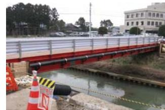
橋梁への空中架設配管施工例
