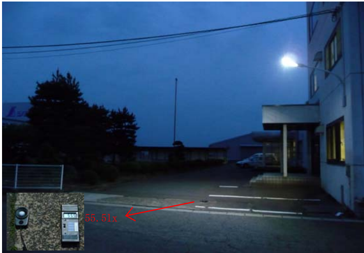
S 社玄関前 壁付け型 LED 外灯(62W) 照度は 55.5lx で大変明るく快適です
