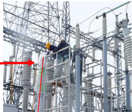
密封栓、放圧管交換作業
