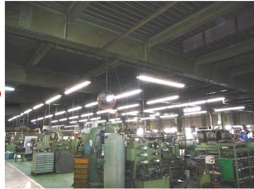
施工後 110W型 LEDランプ 37W (66%省エネ)
