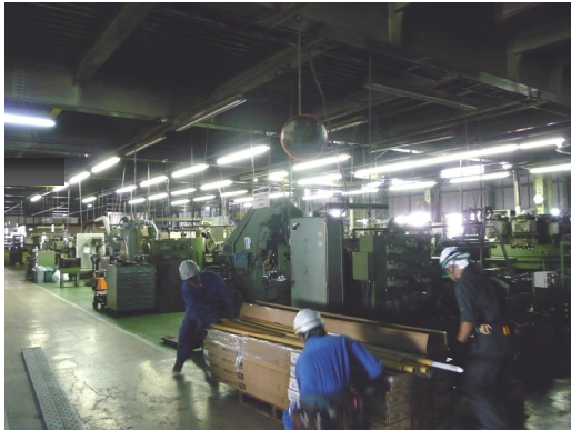
T社 施工前 FLR 蛍光灯 110W
