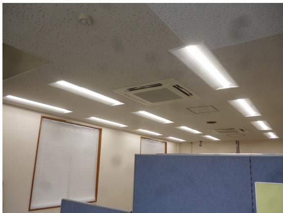
K 社 LED 照明工事
