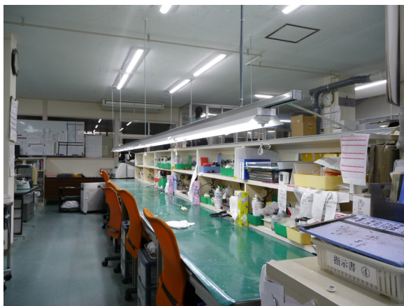
S 社 LED 照明工事
