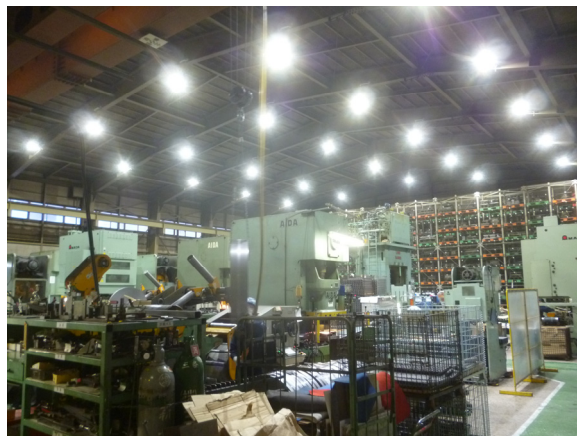
S 社 LED 照明工事
