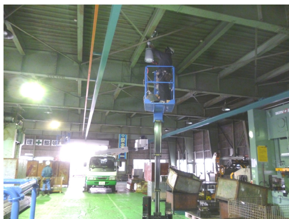
H 社 LED 照明工事
