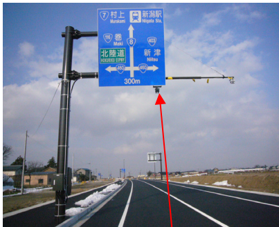
国道 8 号 白根バイパス 車両検知器
