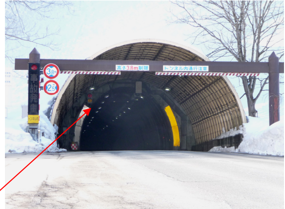
船ヶ沢トンネル (国道 17 号)
