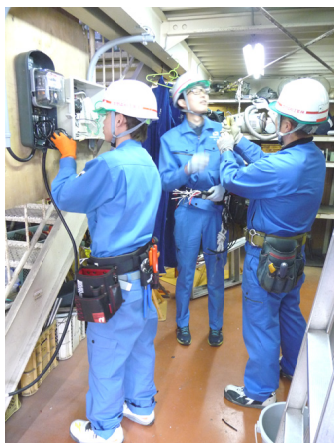
メーター取付工事
