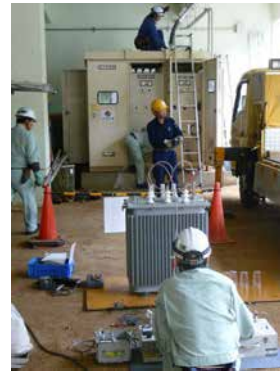
キュービクル改造とトランス耐圧試験
