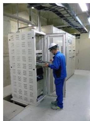
道路情報表示装置主制御機盤
