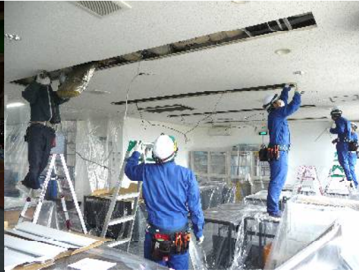
照明器具取付訓練
