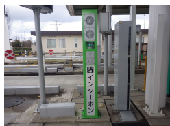
インターホン工事
