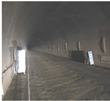
トンネル内(県境表示板)
