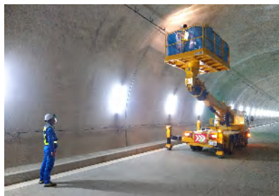
照明器具取付
