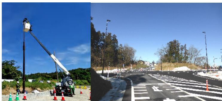
道路照明取付
