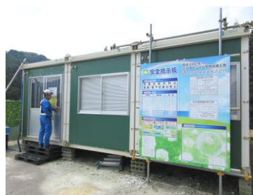
現場仮設事務所
