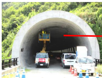
高所作業車と仮設トイレ
