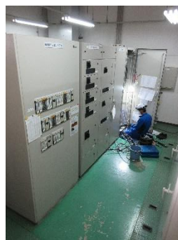
新設制御盤配線作業
